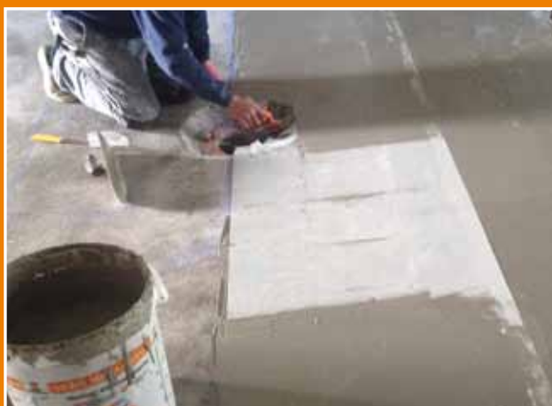
Pose du treillis PRB ARMASEL en continu
