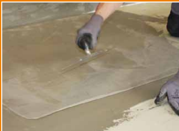
Pose du Treillis ARMASEL en Bande ou en continu
