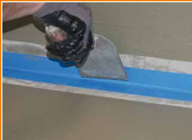
Pose de la PRB Bande renforcée SEBS (intérieur)
